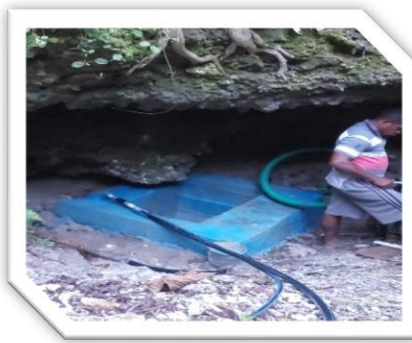
Pembangunan Sistem Penyediaan Air Minum (SPAM) Jaringan Perpipaan di Kampung Tanjung Batu Distrik Sarmi Selatan
