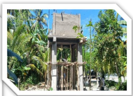
Pembangunan Sistem Penyediaan Air Minum (SPAM) Jaringan Perpipaan di Kampung Ebran Distrik Sarmi Selatan
