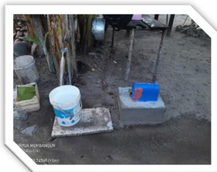
Penyediaan Air Minum dengan kegiatan Pembangunan Sistem Penyediaan Air Minum (SPAM) Jaringan Perpipaan di Pulau Liki Distrik Sarmi
